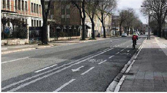
Fotografía 4.9 Via ciclista bidireccional en lateral entre calzada y acera
