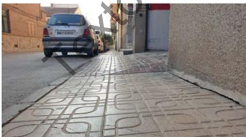
Sería recomendable buscar soluciones más accesibles, como las representadas en los siguientes gráficos (a modo de ejemplo) con la finalidad de mantener el plano de la acera dentro de la inclinación normal de un itinerario peatonal accesible, 2% como máximo de desnivel lateral.
