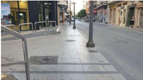
La situación se agrava con los vados vehiculares que atraviesan las aceras, por un mal diseño, en multitud de ocasiones la rampa se hace desde el suelo del bajo hasta la calzada, provocando un desnivel lateral en las aceras muy superior al permitido (2% de desnivel lateral) y en muchas ocasiones imposible de salvar con sillas de ruedas o andadores.
