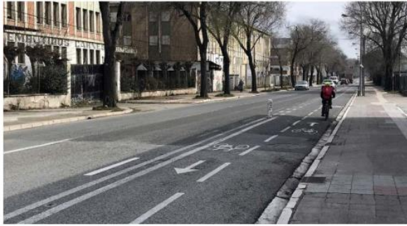
Fotografía 4.9 Vía ciclista bidireccional en lateral entre calzada y acera
