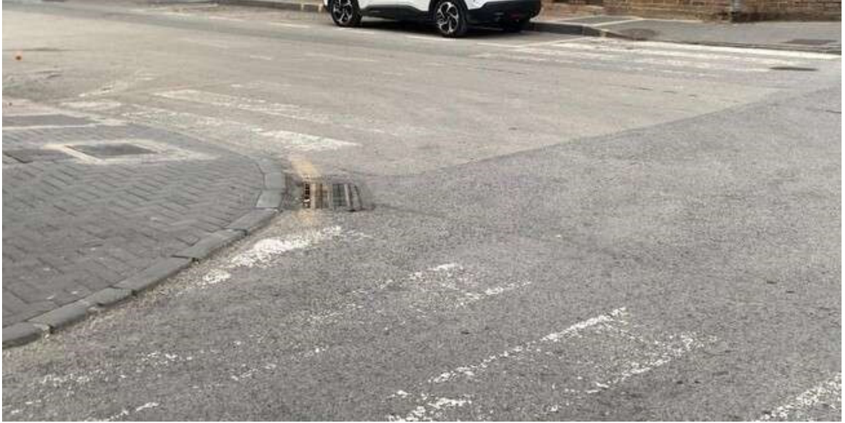
CALLE PINTOR MARIANO BALLESTER, ESQUINA CON CALLE SEVILLA
